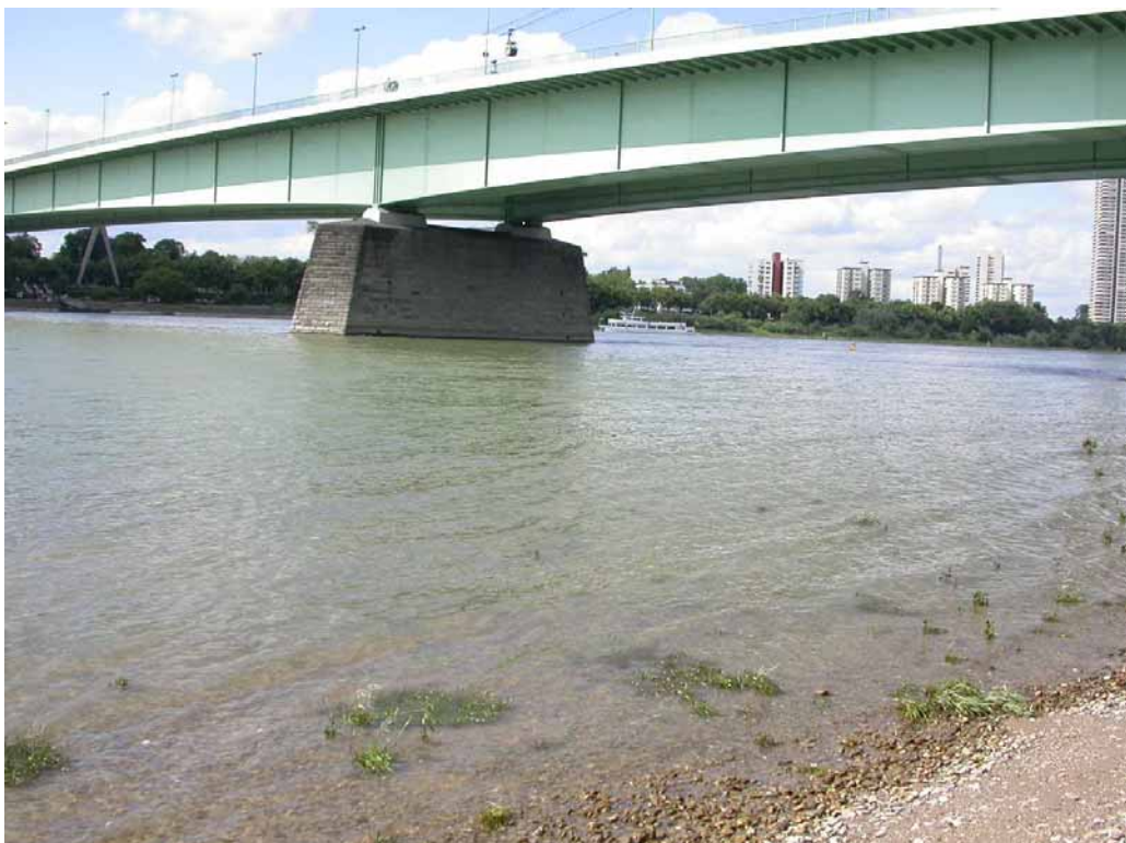
Bild 12: Rheinbrücke mit Seilbahn 2
