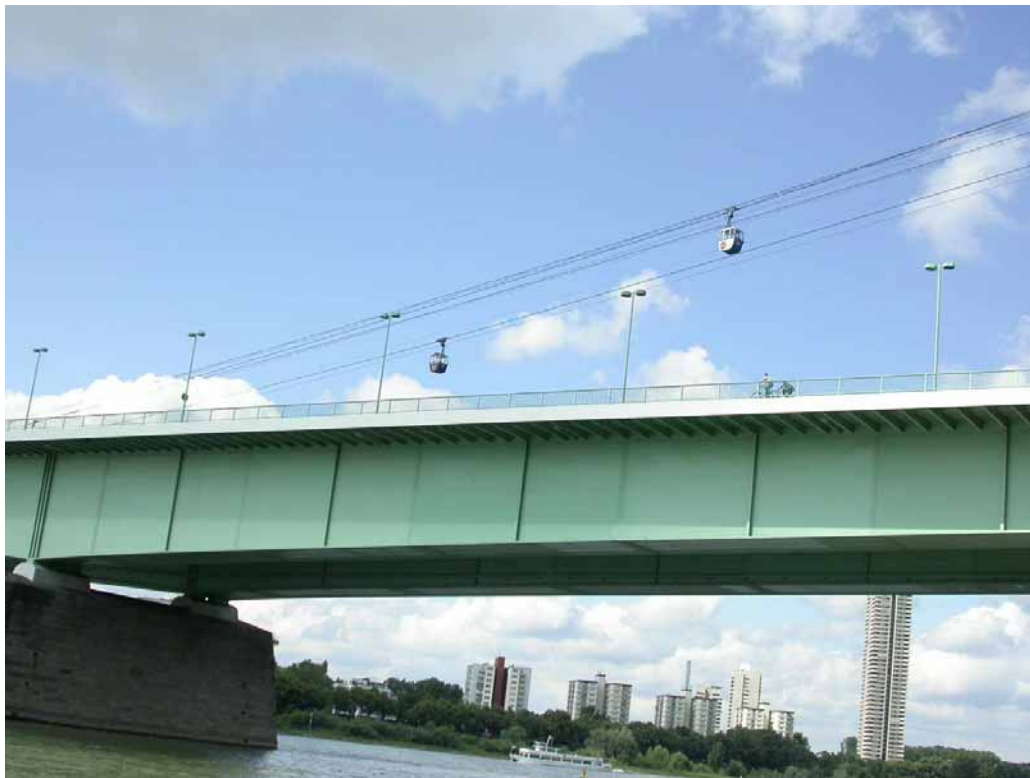
Bild 12: Rheinbrücke mit Seilbahn
